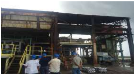
PLANTA DE FUNDICIÓN DE CHATARRA DE PLOMO.
